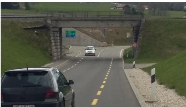
Route cantonale 1320, La Chaux-de-Fonds
