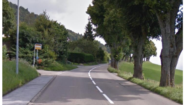
Route des Grattes, Rochefort
