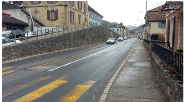
Rue Miéville (route cantonale H10), Travers
