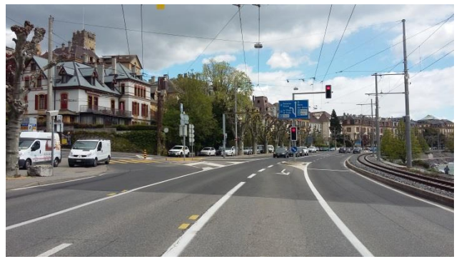
Quai Louis Perrier / Eugène Boret (route nationale N5_VAUS), Neuchâtel
