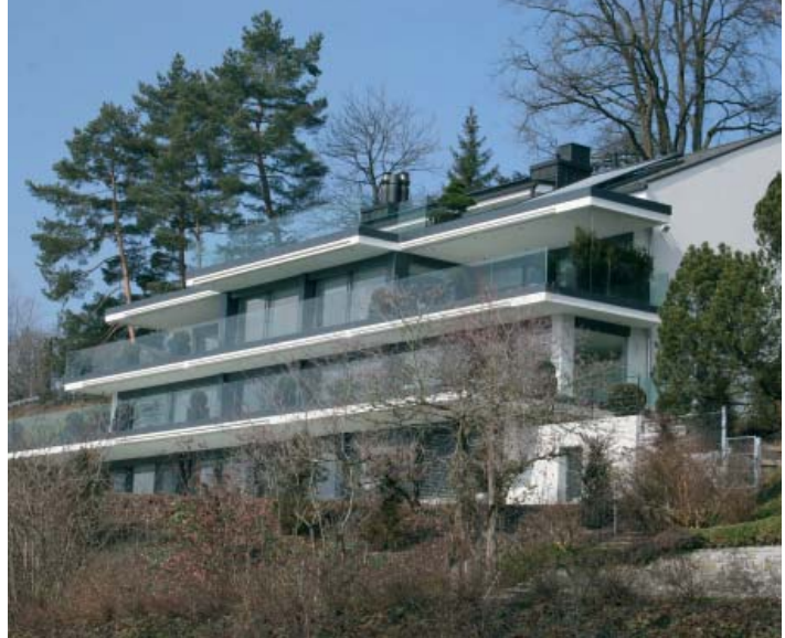
Hautement problématique : un environnement naturel composé de haies et énormément de vitrages totalement transparents...
