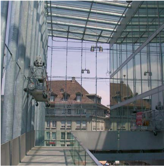
Espace couvert en verre ajouté après la construction à cette gare
