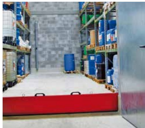
Rétention des fuites/des eaux d'extinction (Photo : Office de l'environnement, TG)
