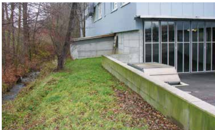
Protection d'un entrepôt de produits chimiques contre les crues (Photo : Office de l'environnement, TG)
