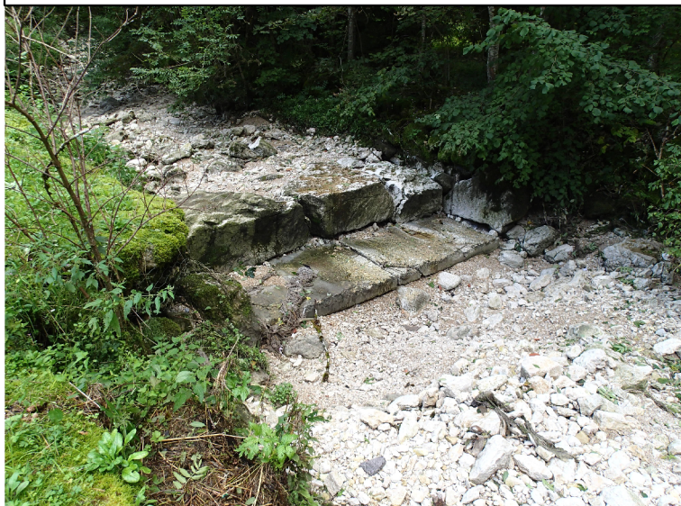
Second obstacle artificiel infranchissable depuis l'emplacement de l'usine de turbinage sur la partie amont de la Rançonnière
